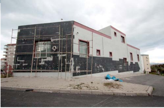
Cemevi Dış Cephe Mantolama Çalışmaları
