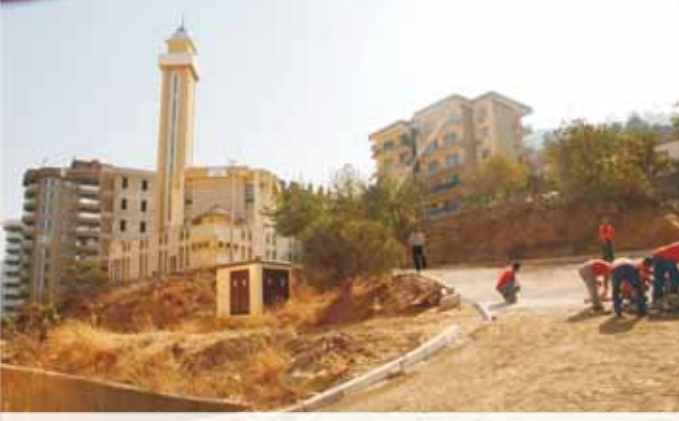
Ilica Mah. Kutlu Yalvac Camii Etrafı Yol Çalışması
