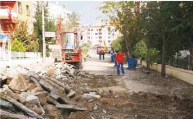
Ahmet Haşim Sokak Parke, Yol Çalışması
