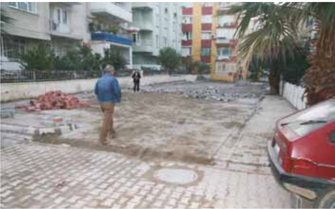
Narlı Mahallesi Bekaroğlu Sokak Parke, Yol Çalışması
