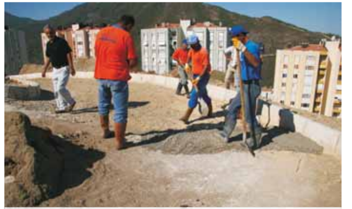
2. İnönü Mah. Hasan İçyer İlköğretim Okulu Yol Çalışması
