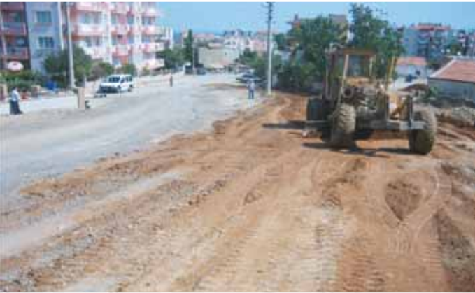
Çatalkaya Mahallesi Aras Sokak Asfalt Çalışması
