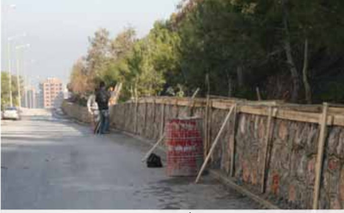
Narbel, Narkent Konutları İstinat Duvarı Yapımı
