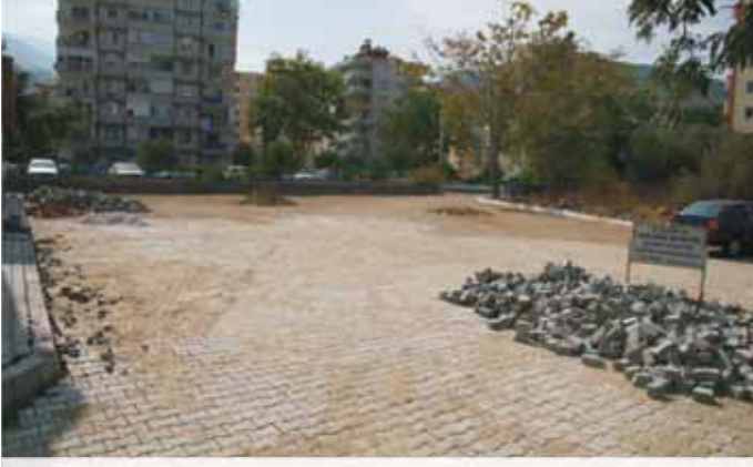
Çamtepe Mahallesi Meydan Çalışması
