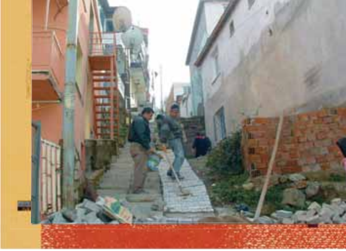
Diyar Sokak Merdiven ve Yol Yapımı
