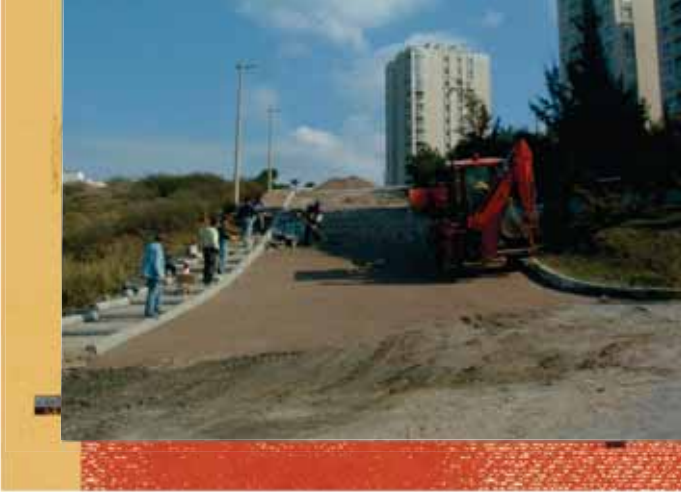
Arıkent Saffet Baba Sokak Başlangıcı Merdivenli Yol Yapımı
