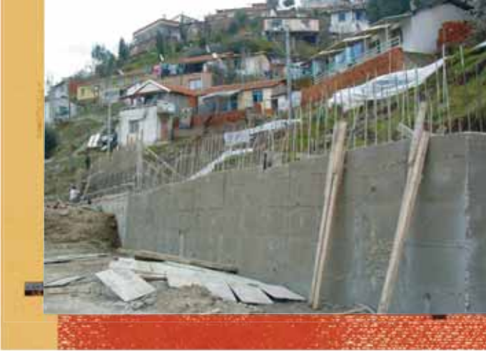
Teknik Hizmetler Binası Yanı Süha Sokak İstinad Duvarı Yapımı
