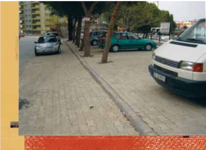
Körfez Sokak Parke Yol Yapımı
